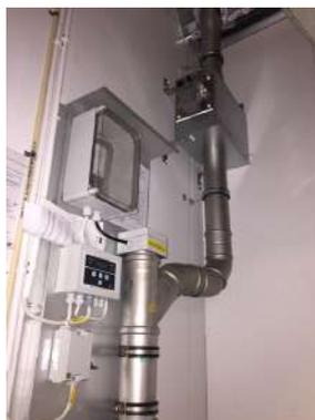
Configuración afuera del Ducto con Accesorios (ion-1000 o ion-2000 instalado dentro de un armario, conectado al ducto vía una línea de by-pass)
